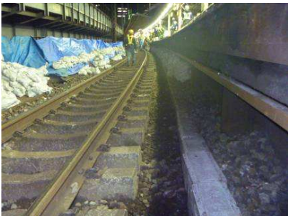
②砕石撤去後状況
