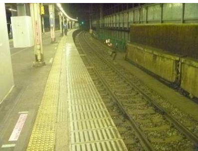
③施工後の状況
