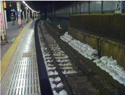
①砕石の袋詰土のう袋置換え状況
