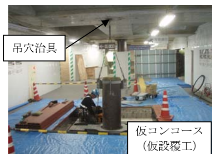
写真-3 鋼管柱設置状況
