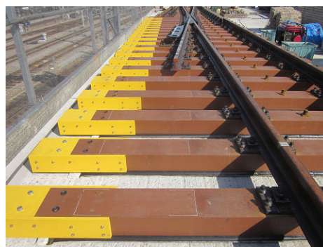
図-7 プロテクタ設置状況図
