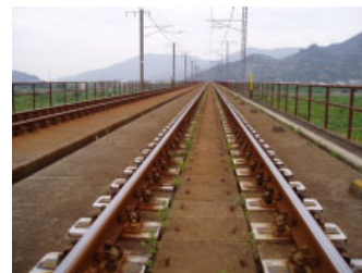
写真-2 B型敷設区間全景
