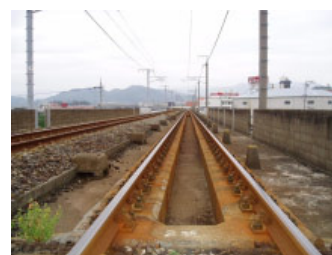
写真-3 C型敷設区間全景
