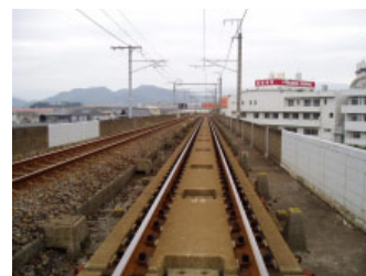
写真-4 D型敷設区間全景
