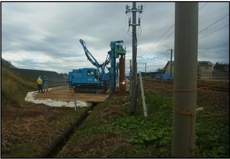
写真 1 施工状況（NS エコパイル）
