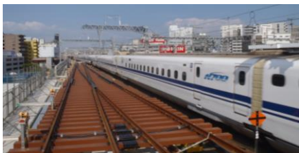
写真-1 分岐器組立状況
