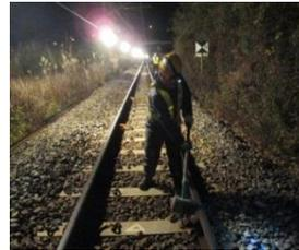
写真-1 掛矢による打撃作業
