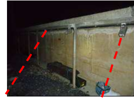
写真 - 5 沈下量測定状況
