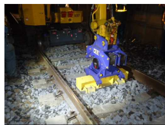
写真-2 マクラギ加振工法
