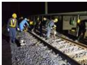
写真-1 通常つき固め
