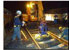
写真 - 4 施工状況
