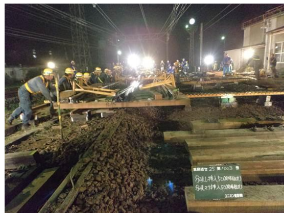
写真-2 新分岐器の挿入（ソロバン）
