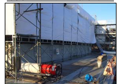
写真-2 ヒーターによる養生
