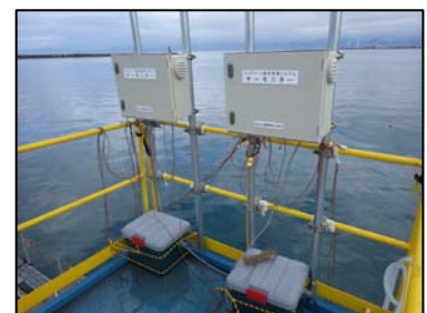
写真-1 計測BOX設置状況
