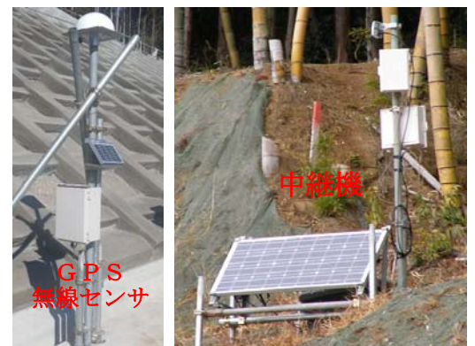
写真-3 GPS 無線センサと中継機の設置状況
