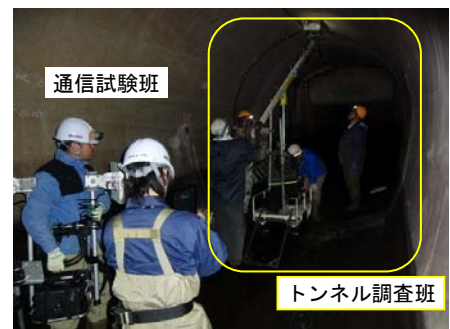
図-4 坑内通信試験状況
