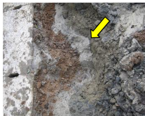
写真-4 遮水材料の充填状況
