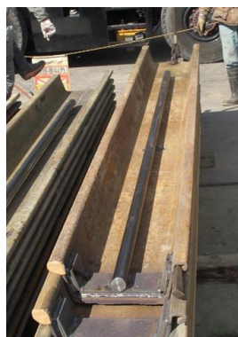
写真-1 下杭の先端補強と充填管
