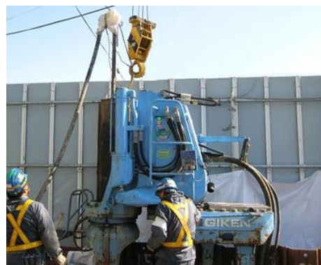
写真-2 圧送管取付状況
