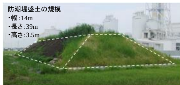
写真 1-1 防潮堤盛土の全景写真
