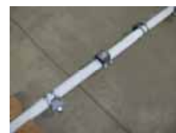
写真-2 取付状況
