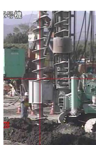
写真-1 杭の打設状況
