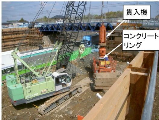
写真-1 施工状況 (貫入機設置)
