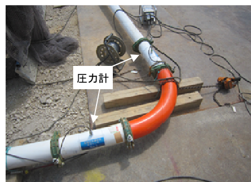
写真-1 圧力計の設置状況
