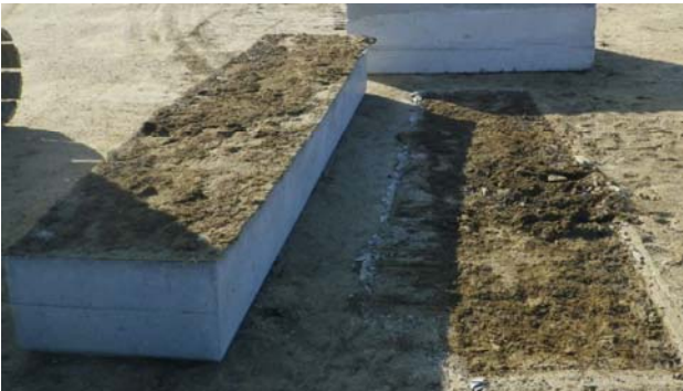
図 4 供試体下面状況
