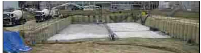
写真-3 ラップルコンクリート打設
