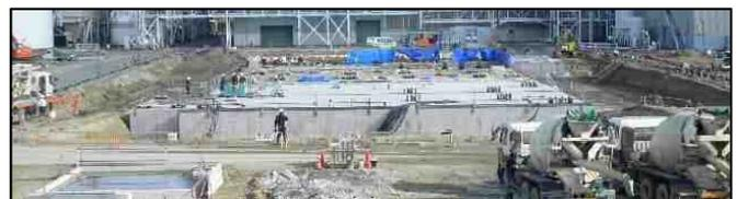
写真-4 基礎コンクリート打設
