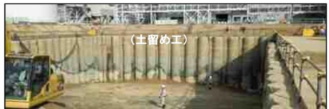
写真-2 軟弱地盤の掘削
