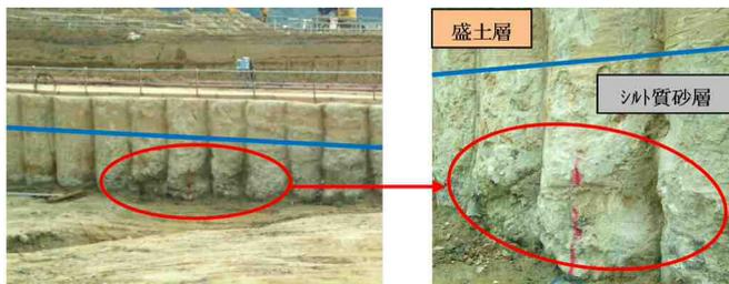
写真-1 シルト質砂層改良体の表面剥離の例
