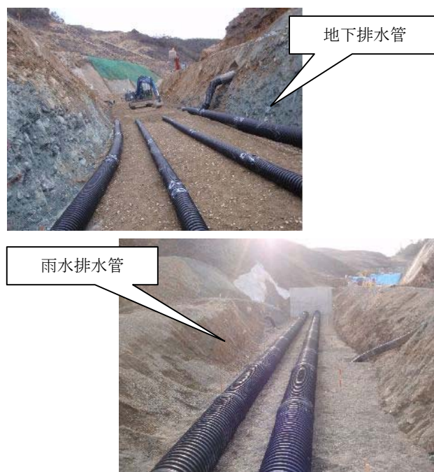
写真-1 排水対策工(流末部)
