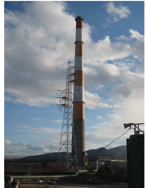
写真-1 煙突外観(着手前)
