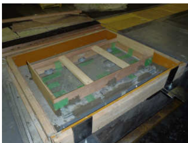
写真-2 箱抜き型枠設置
