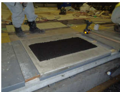
写真-5 常温合材舗設
