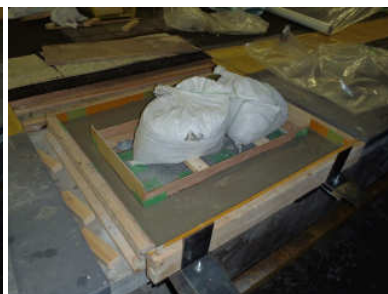
写真-3 無収縮モルタル打設
