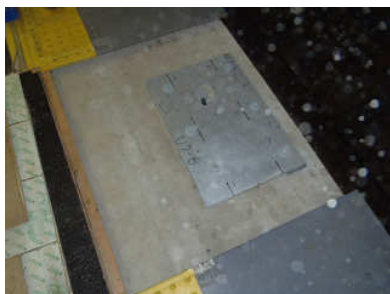
写真-1 横置・木製覆工板撤去
