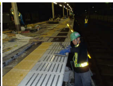
写真-6 先端タイル設置
