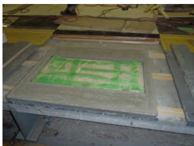
写真-4 脱型、シート敷き
