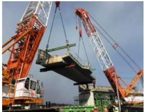
写真1 桁撤去状況
