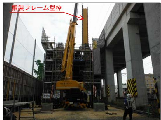
図-5 鋼製フレーム型枠の設置状況
