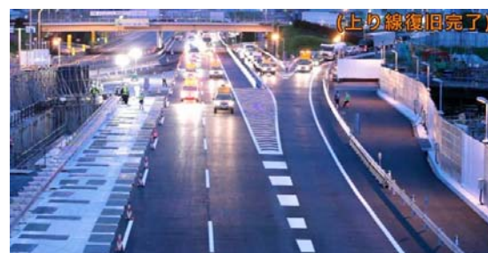
写真-5 先頭固定規制状況(上り線迂回復旧時)
