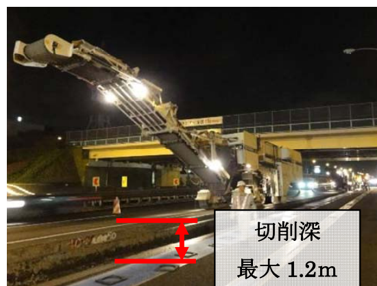
写真-4 切削状況写真
