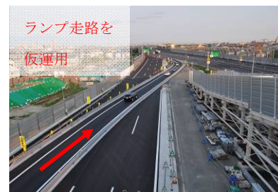
写真-3 上り線迂回復旧 本線切替前状況 東京側
