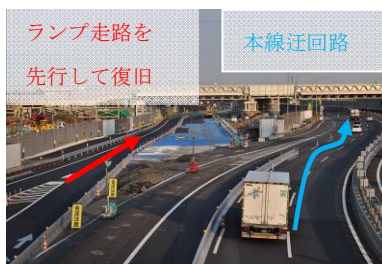
写真-2 上り線迂回復旧 本線切替前状況 千葉側
