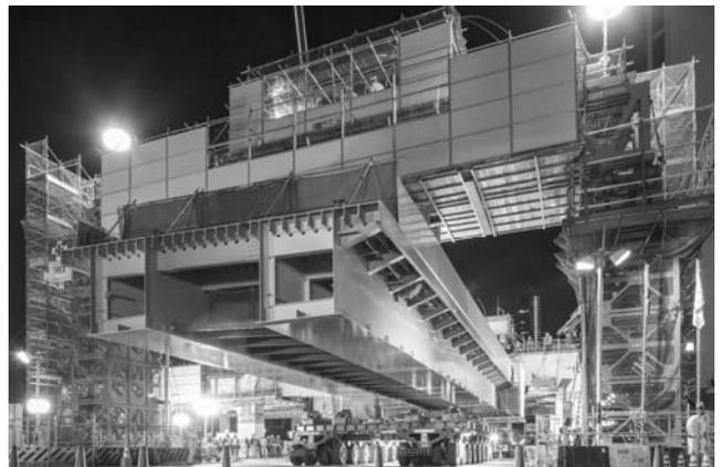
写真-1 吊上げ架設状況（仕口は、交差点上）
