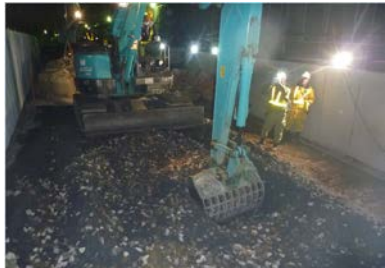
写真-4 スケルトンバケットによる攪拌状況
