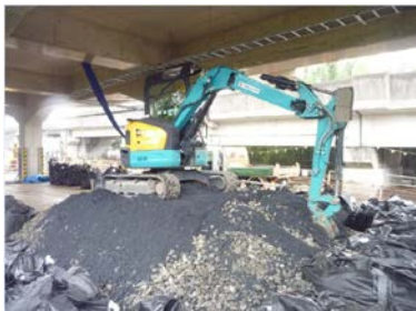
写真-2 攪拌状況
