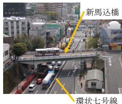
図-1 架替工事着工前の新馬込橋
