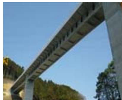
写真-1 上り線の完成全景
