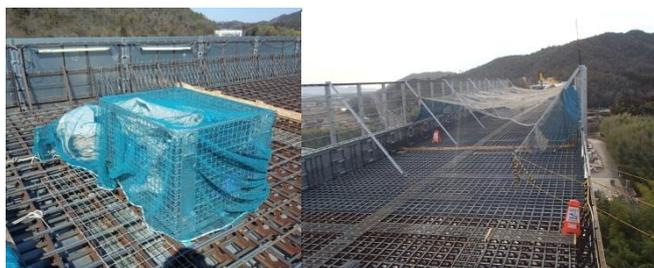
写真1 飛来物防止のための養生
