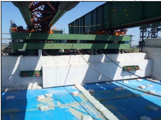
写真-2 桁前方部の反力受け架台
