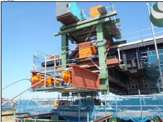
写真-1 桁後端部の引込み装置
