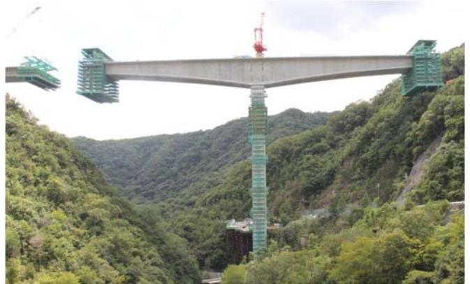
写真-1 P2 張出し施工
