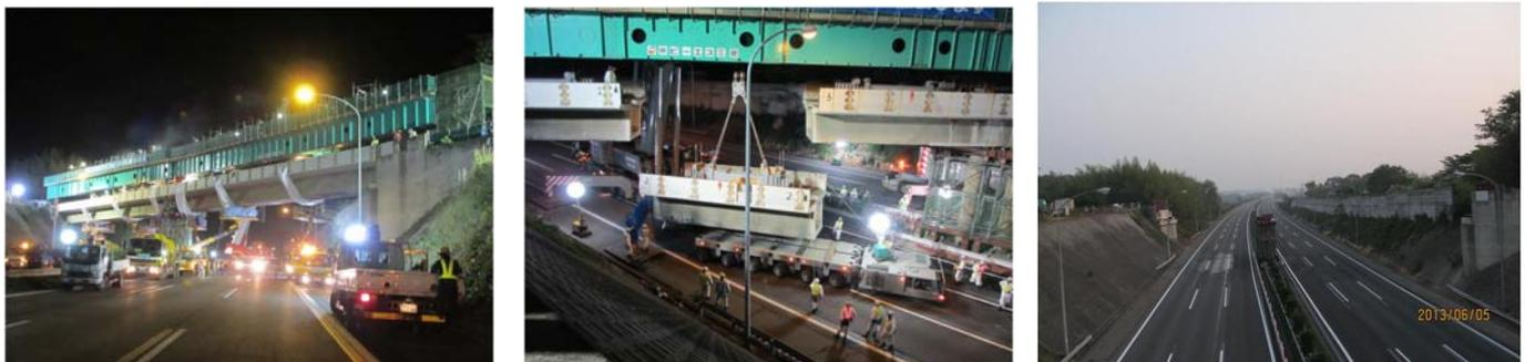
写真 - 1 撤去状況(左:橋体切断, 中央:橋体降下, 右:撤去完了)
