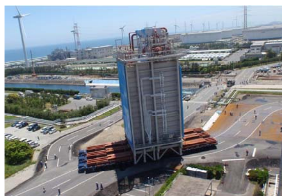
写真—2 HRSG 通行状況
