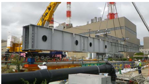
写真—1 6連取水路横断箱桁—架設状況
