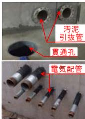
壁や床に、給水管や貫通孔および電気配管といった多種の埋込管が、複数本設置
