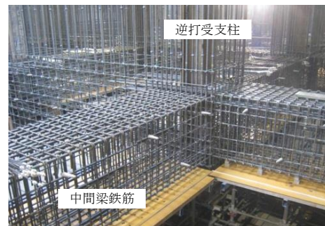
写真-3 柱部の実配筋状況
