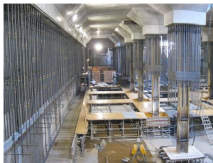
写真-2 実施工での逆打ち施工状況
