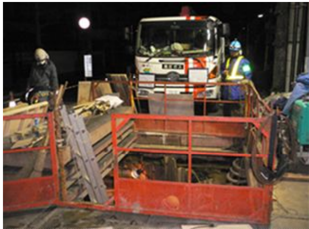
写真 4,5 現場パトロール
