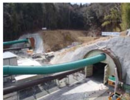
箕面トンネル東坑口
