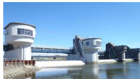
写真-1 行徳可動堰の全景
