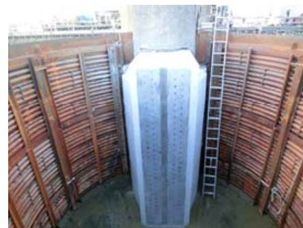
写真-2 堰柱端部仮締切内部
