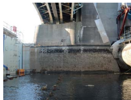
写真-3 仮締切ゲート内の排水完了
