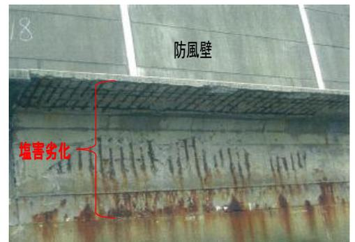
写真-1 既設護岸の塩害状況
