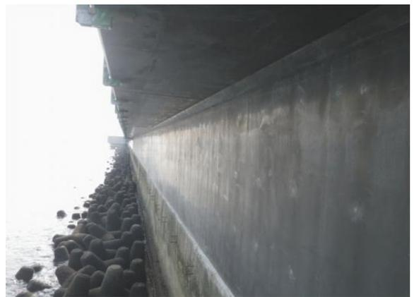
写真-2 常温硬化型 UFC 施工完了状況
