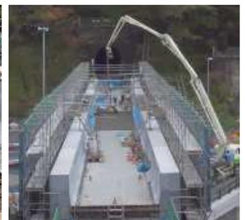
写真-5 鉄筋・埋設型枠設置状況 写真-6 コンクリート打設状況
