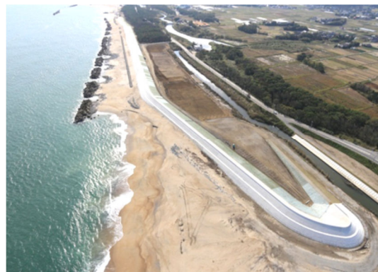
写真-1 CSG 海岸堤防全景
