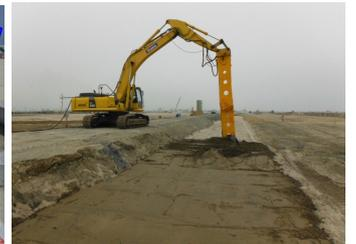
写真 - 4 地盤改良施工状況(SCM 工法)
