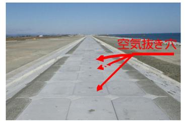
写真 - 2 天端コンクリート空気抜き穴
