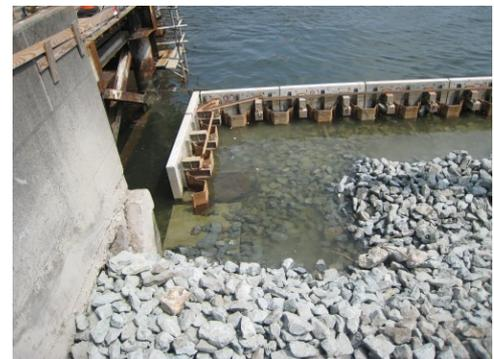
写真-3 プレキャストコンクリート設置状況
