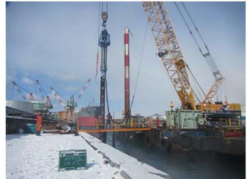
写真-2 鋼矢板打設状況
