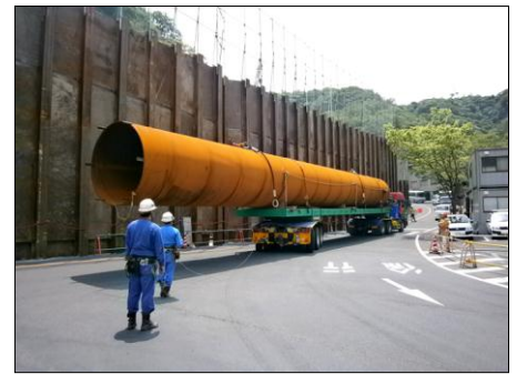
写真-2 鋼管杭場内運搬
