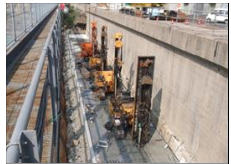
写真-1 先行削孔状況
