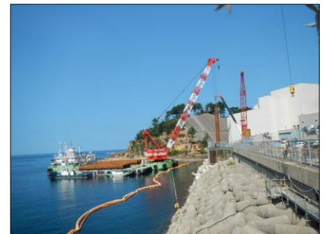
写真-3 内挿鋼管海上施工
