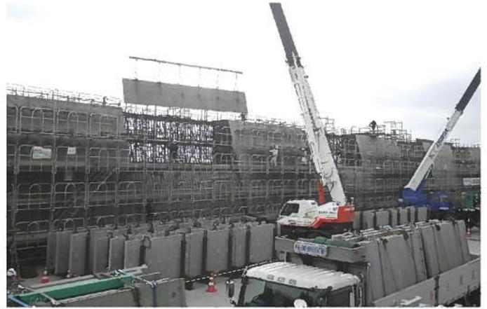
写真-1 プレキャストコンクリート型枠設置状況
