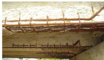
写真2 耐荷力低下の危険性が高い損傷
