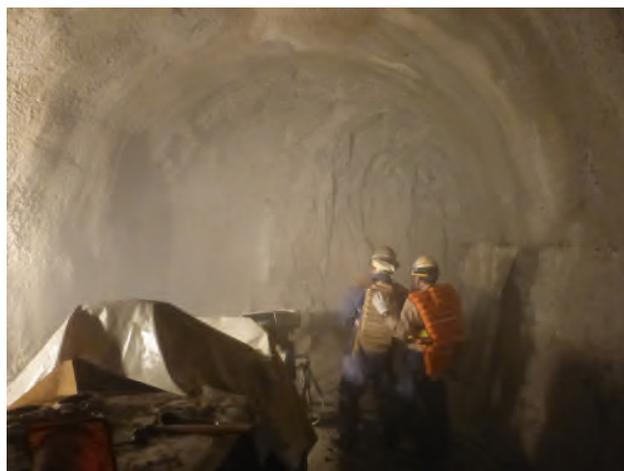
図-2 吹付け施工状況写真
