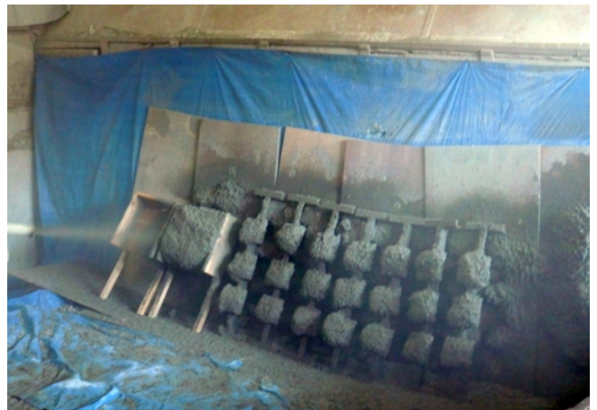
写真-1 試験吹付けの状況 (試験場所：地上のズリピット)
