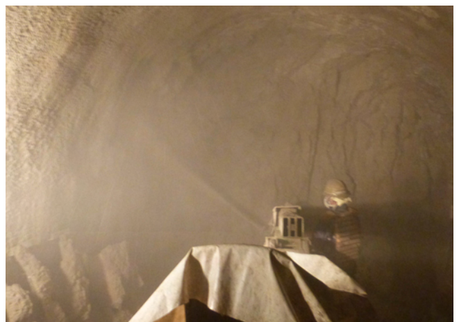
写真-2 施工性確認試験の状況 (試験場所：坑道内)
